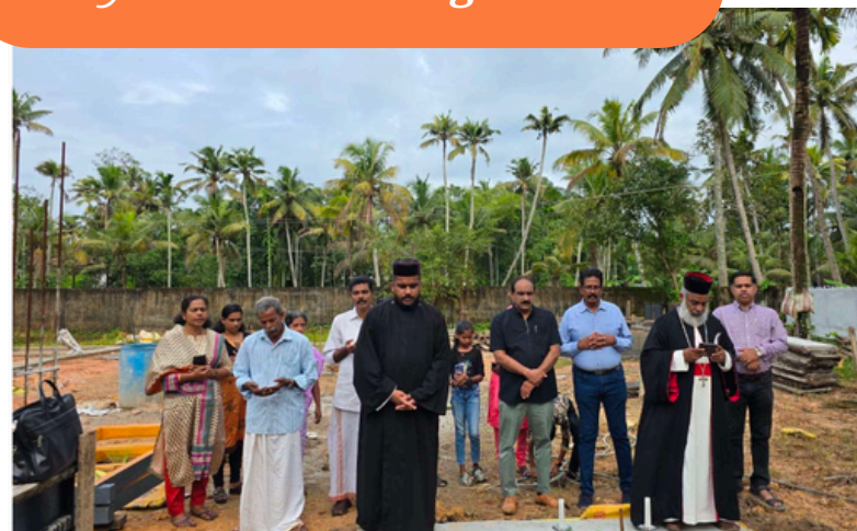
Hjørnestensnedlæggelse til det 7. hus og opsætning af hoveddør til to huse i Y's Men Village Karthikappally den 27. august.
