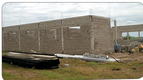
Nye bygninger under opførelse.
